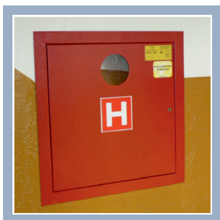
Stav po rekonstrukci
