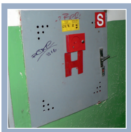
Stav před rekonstrukcí
